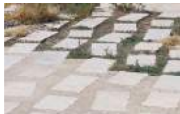
Pavés béton transition avec joints végétalisés
