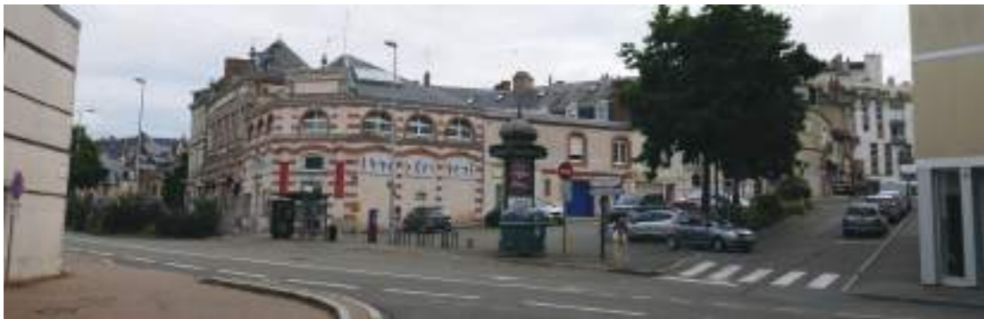
Vue sur la place de l'Hôpital depuis la rue Barbier
