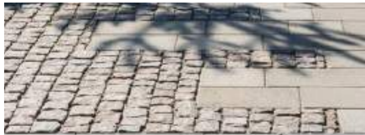
Assemblage de pavés anciens et dallage granit
